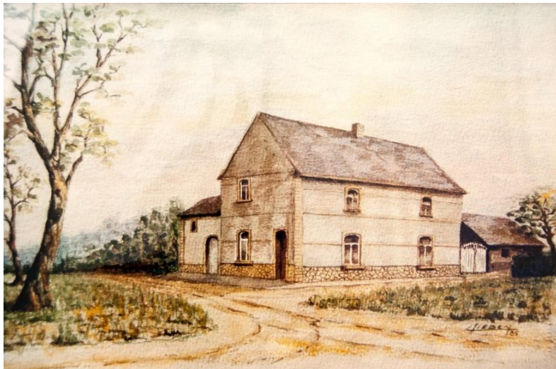
De Tramhalte, geschilderd door Albert Lieben
