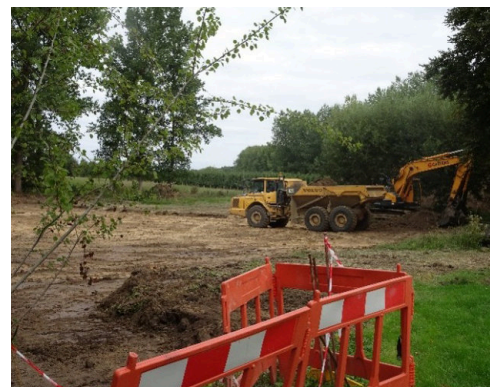
Aanleg van het waterbekken in de Stintelaarstraat in augustus 2018
